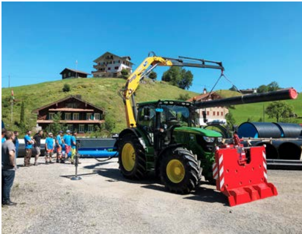
Instruktion von neuem Verlegefahrzeug für den Rohrleitungsbau
