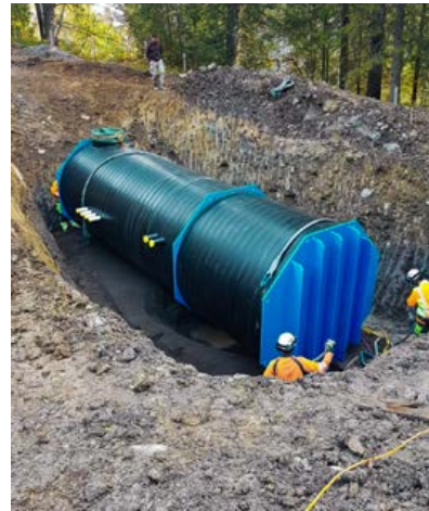
Neues Reservoir Genossenschaftskorporation Emmetten, Teufelsboden
