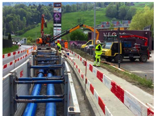
Verlegearbeiten für die Seenergy-Leitung ewl Luzern
